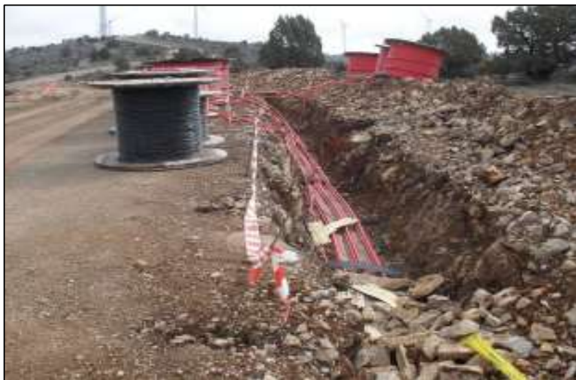
Figura 6. Zanjas y tendido del cable
