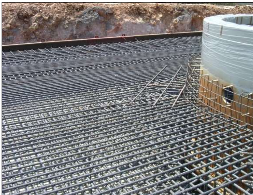
Figura 5. Estructura metálica de la cimentación y brida de la torre
